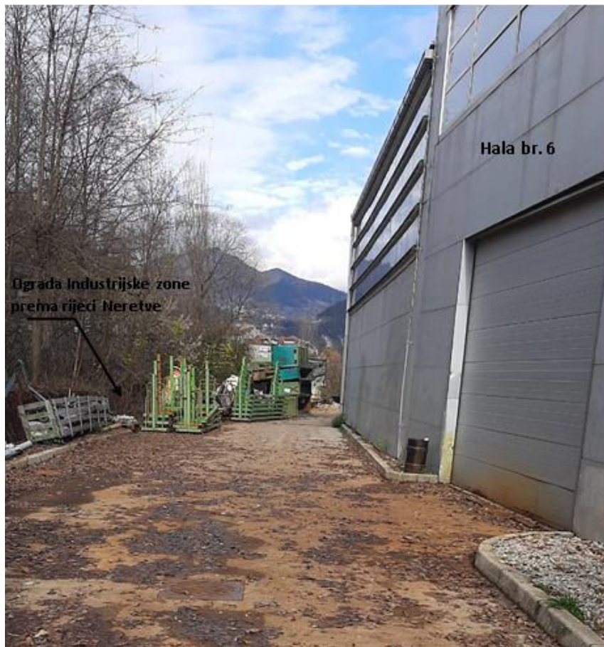
Slika A.5. Pristupna saobraćajnica lokaciji pogona operatera PD „Galvanorm“ d.o.o. Konjic locirana između hale br. 6 i ograde prema rijeci Neretva
